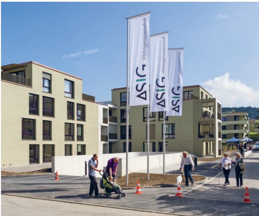
Tägelmoss ist die erste ASIG-Siedlung in Winterthur und mit 89 Wohnungen eine der grösseren.
